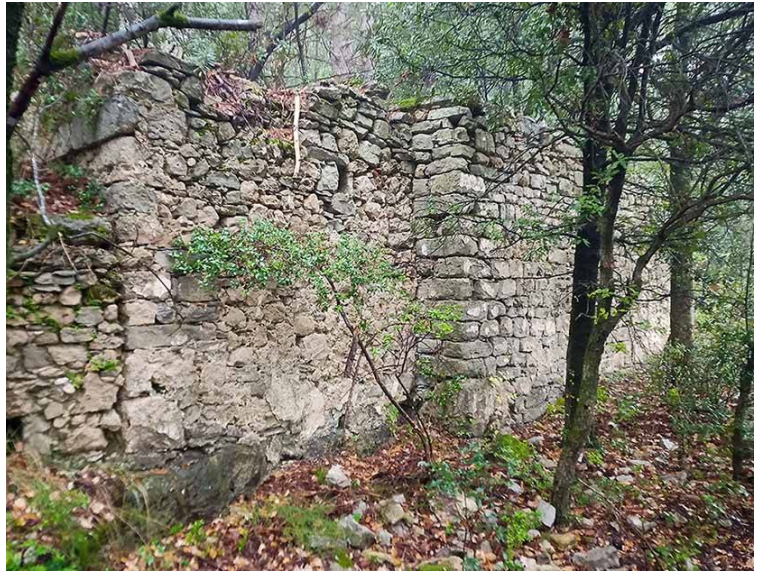
Figure 7. Différentes générations de murs accolés.
